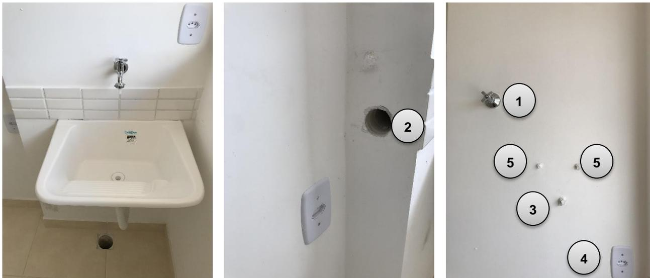
Legenda: 1) Registro de gaveta; 2) Ponto de esgoto - MLR; 3) Ponto de gás do Aquecedor; 4) Ponto elétrico - MLR; 5) Ponto de água.
